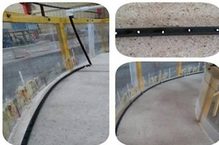
شکل 2 نحوه کارگذاشتن سازه حفاظتی
