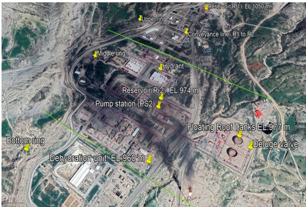
Fig. 1 General location of the refinery site شکل ۱ موقعیت کلی سایت پالایشگاه
