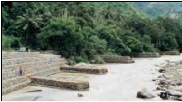
شکل 1 نمونه‌ای از آب‌شکن متخلخل اجرا شده در ایران (خسروی، 1393)
