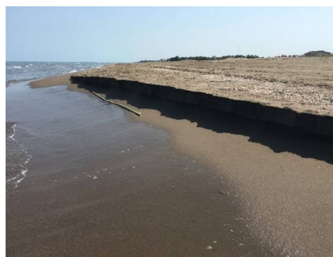
شکل 16 تراس فرسایشی ساحل غربی
