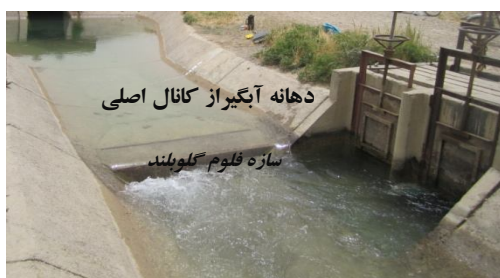
شکل 2 نمونه‌ای از سازه فلوم گلوبلند موجود در شبکه آبیاری درودزن (ابتدای کانال T19)
