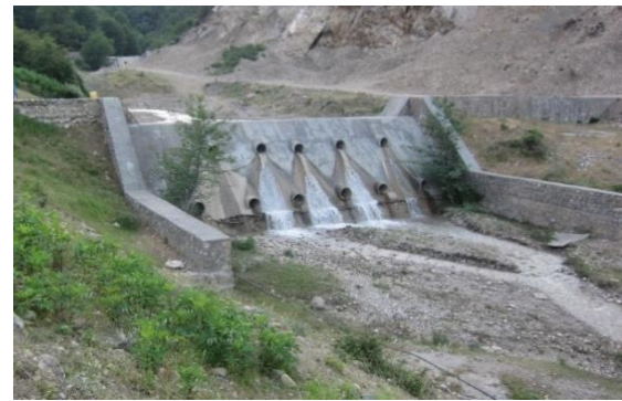
Fig. 1 Masonry check dam (Tul Bene) شکل ۱ تصویر بندسنگی ملاتی تول بنه
